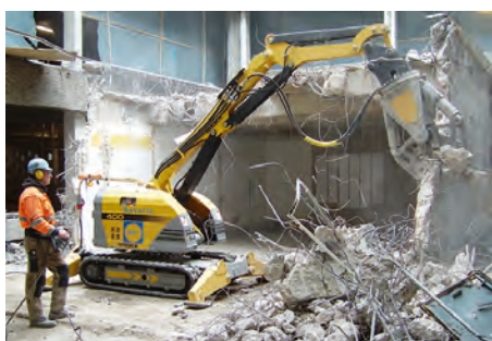
Zange mit Doppelbrechzähnen
